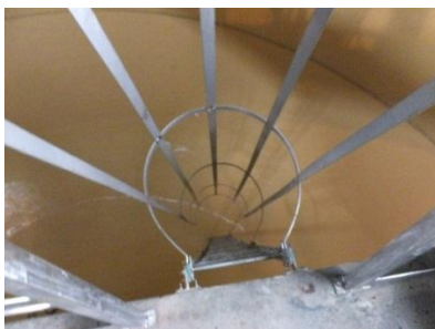
Vue plongeante sur le réservoir d'eau
