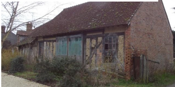
Maison de la Grande Rue, à Chaon © L. Stainier
