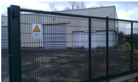
Nouveaux ateliers – Route de Salbris
